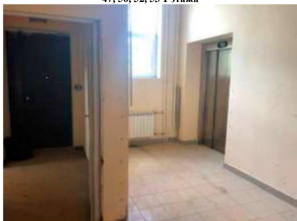
Помещение, назначение: нежилое, площадь 2425,9 кв.м., поз. 47, 50, 52, 53 1 этажа
