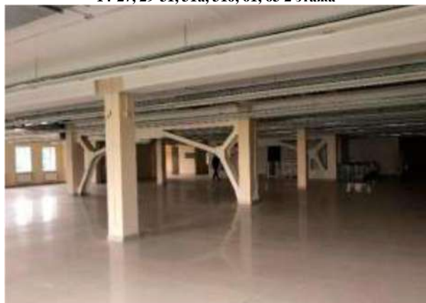
Помещение, назначение: нежилое, площадь 2425,9 кв.м., поз. 14-27, 29-31, 31а, 31б, 61, 63 2 этажа
