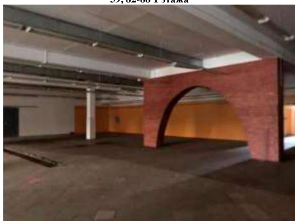
Помещение, назначение: нежилое помещение, площадь 2237,7 кв.м., этаж 1, позиции 27, 27а, 27б, 27в, 27г, 28-31, 31а, 31б, 32-35, 35а, 36-41,41а, 42, 42а, 43, 43а, 43б, 43в, 44-46, 48, 48а, 54-57, 59, 82-88 1 этажа
