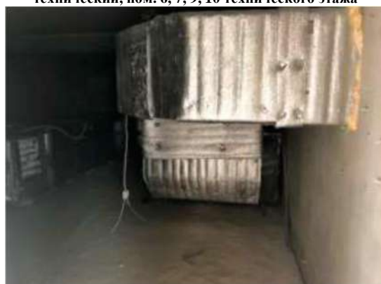
Помещение, назначение: нежилое, площадь 94,1 кв.м., этаж: технический, пом. 6, 7, 9, 10 технического этажа
