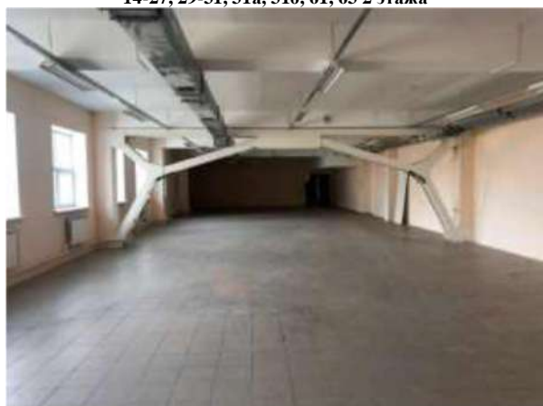
Помещение, назначение: нежилое, площадь 2425,9 кв.м., поз. 14-27, 29-31, 31а, 31б, 61, 63 2 этажа
