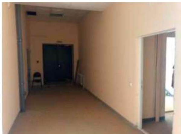
Помещение, назначение: нежилое, площадь 2425,9 кв.м., поз. 47, 50, 52, 53 1 этажа
