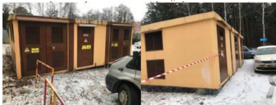
Здание, назначение; нежилое здание, площадь 33,3 кв. м, количество этажей: 1, адрес (местонахождение) объекта: Российская Федерация, Республика Башкортостан, г. Уфа, Советский р-н, ул. Менделеева, д. 158. Кадастровый номер: 02:55:010715:1403 (с учетом прав землепользования);
