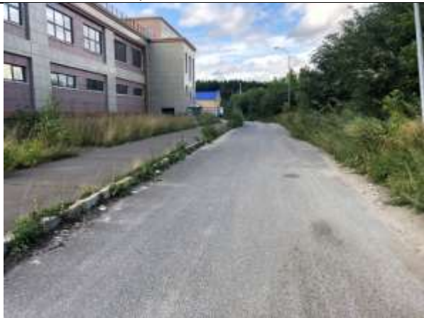
Часть автостоянки на 225 машиномест (Автостоянка на 120 машиномест), назначение: нежилое, площадь 5440 кв. м, количество этажей: 1
