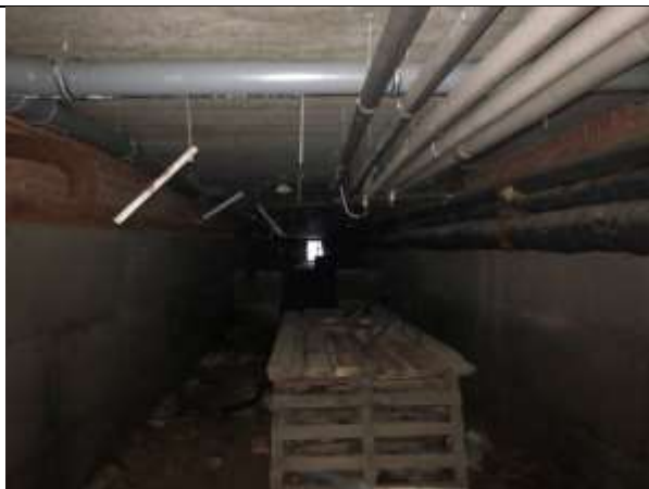
Помещение, назначение: нежилое, общая площадь 944,3 кв.м, этаж: подвал, 1, 2, технический этаж, помещения поз. 6-15 подвала, помещения поз. 49, 51, 57а, 57б, 58, 60, 1 этажа, помещения поз. 28, 32, 33, 2 этажа, помещения поз. 8, 11-16 технического этажа
