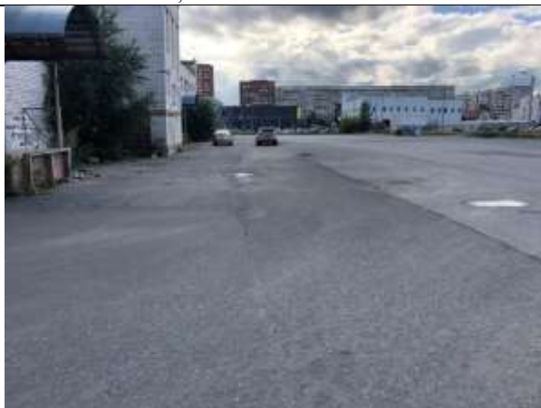
Часть автостоянки на 225 машиномест (Автостоянка на 120 машиномест), назначение: нежилое, площадь 5440 кв. м, количество этажей: 1
