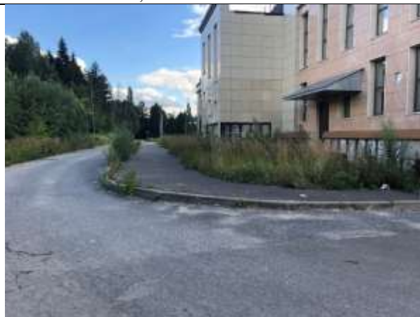
Часть автостоянки на 225 машиномест (Автостоянка на 120 машиномест), назначение: нежилое, площадь 5440 кв. м, количество этажей: 1
