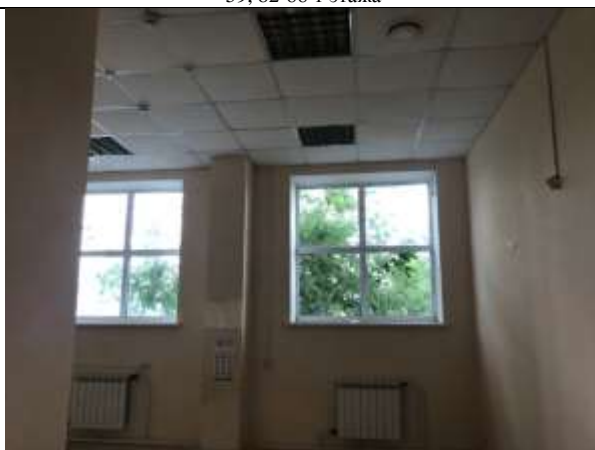
Помещение, назначение: нежилое помещение, площадь 2237,7 кв.м., этаж 1, позиции 27, 27а, 27б, 27в, 27г, 28-31, 31а, 31б, 32-35, 35а, 36-41,41а, 42, 42а, 43, 43а, 43б, 43в, 44-46, 48, 48а, 54-57, 59, 82-88 1 этажа
